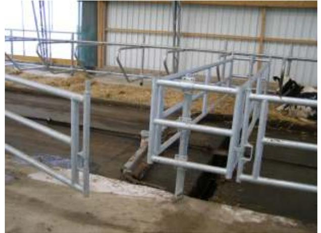
**Absperrgitter ausziehbar mit Rohrsticket**
