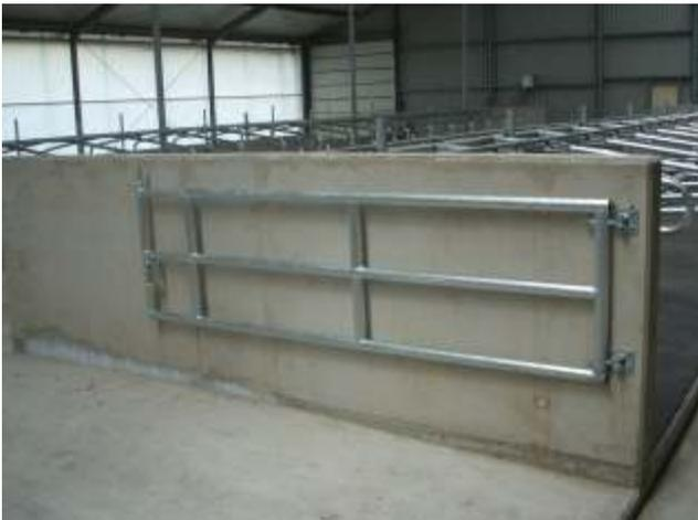
**Absperrgitter mit doppeltem Überwurf**
