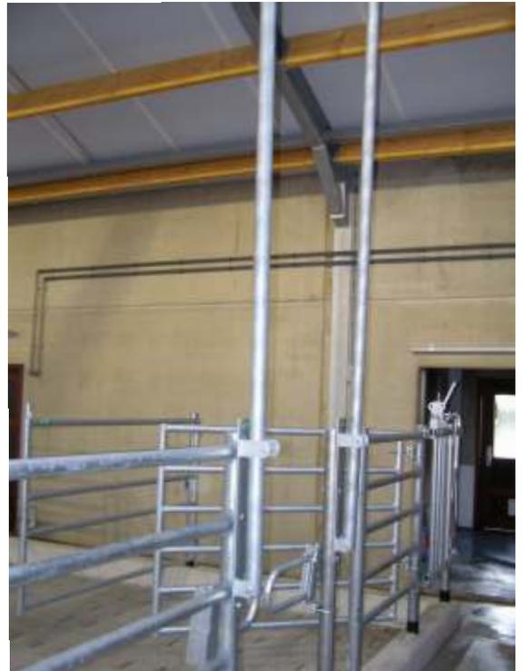
**Rücklaufsperre mit einem Rohr**
