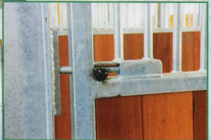
Verriegelung der schwenkbaren Trenngitter
