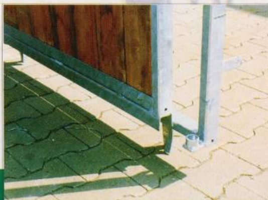
Innenliegende Führung der Schiebetüren
