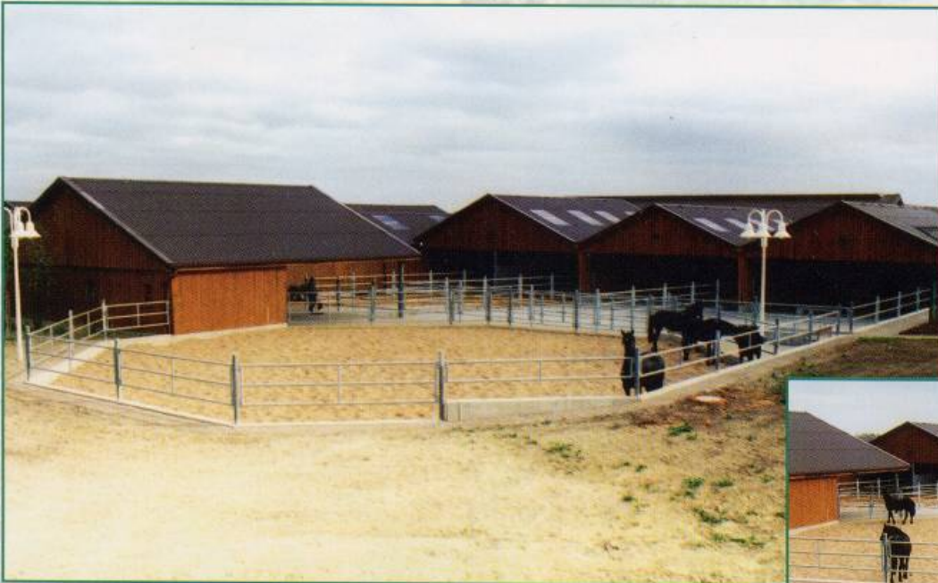
Anlage mit Offenställen sowie Paddock
