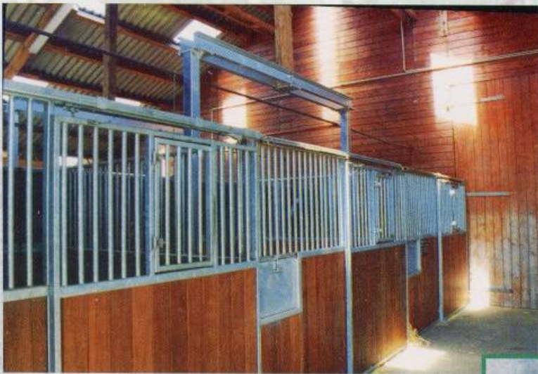
Trenngitter mit zusätzlicher Stütze sowie Querträger zur Aufnahme der Dachkonstruktion
