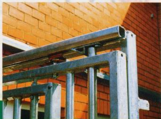
Verriegelung bei Schiebetüren
