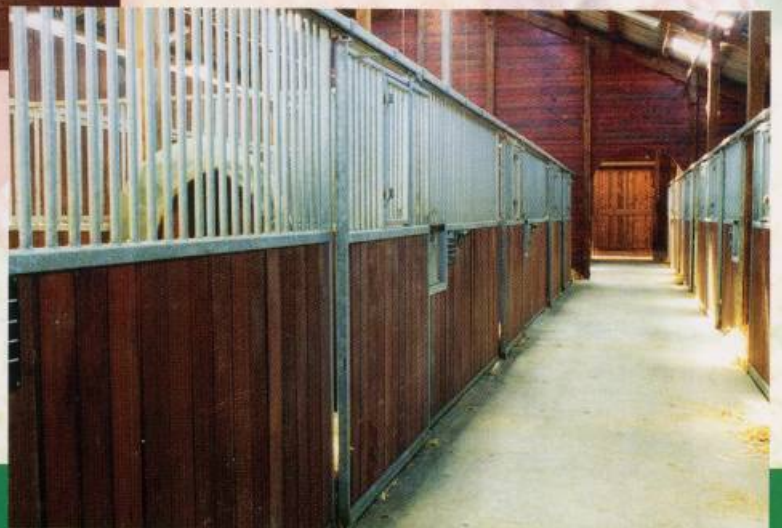
Ausführung: Frontgitter mit Schiebetüren sowie Klapptrog
