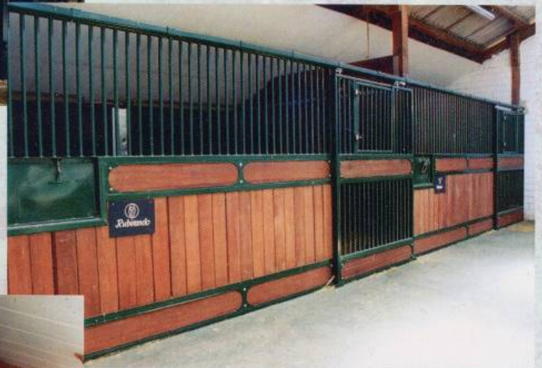
Ausführung: feuerverzinkt und Duplex-beschichtet mit Schiebetür sowie Bongossiholz
