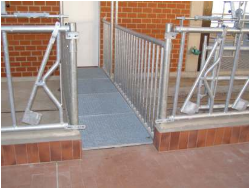
Übergang vom Futtertisch zum Roboterraum
