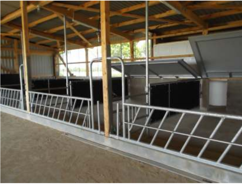
Kälberhimmel mit Hohlkammerplatten und Handkurbel
