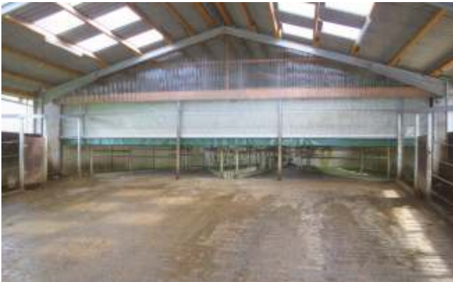
Rollofront mit Antrieb mit Rohrmotor
