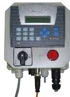
Schaltkasten mit SPS-Steuerung
